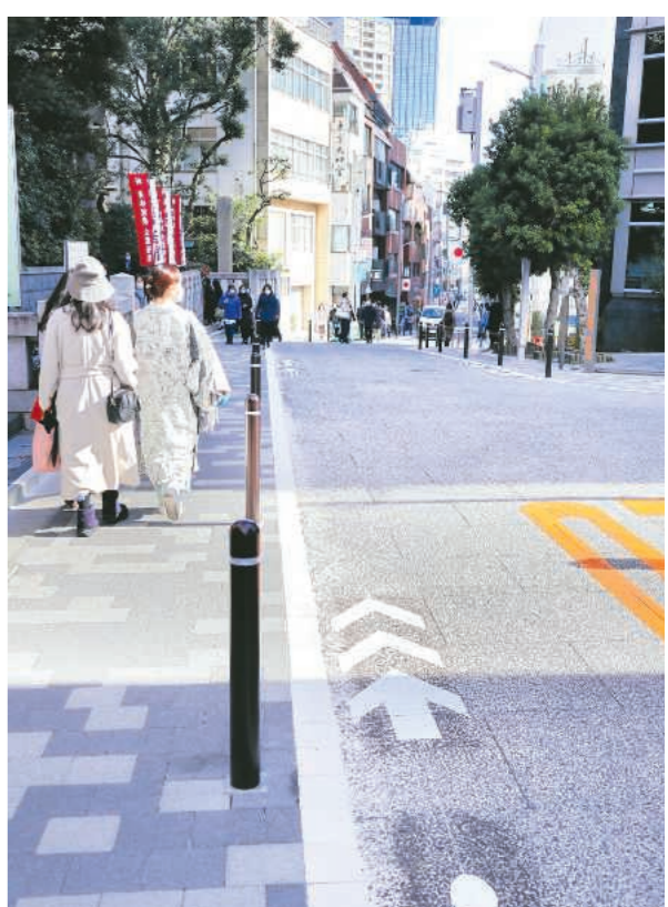
電線類が無くなり石畳風に舗装された参道
