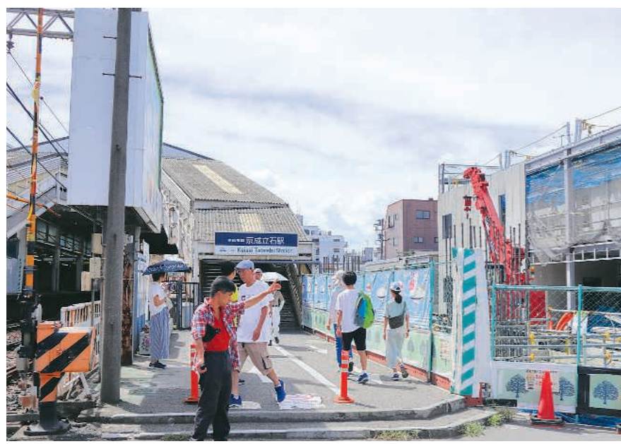
解体工事が始まった立石駅北口
